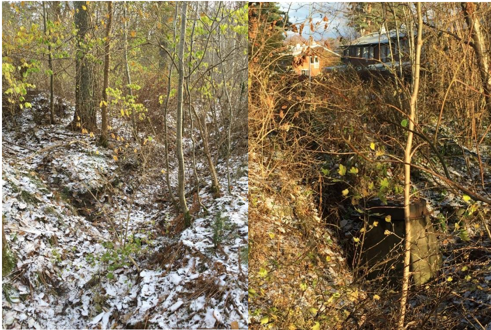
Figur 8. Lågpunkt norr om planerad skola innan radhusområdet. T.v. diket som avleder och fördröjer dagvattnet från naturområdet uppströms planområdet samt uppströms planerad skola. T.h. Dagvattenbrunn i lågpunkten innan dagvattnet går in i ledningsnätet.
