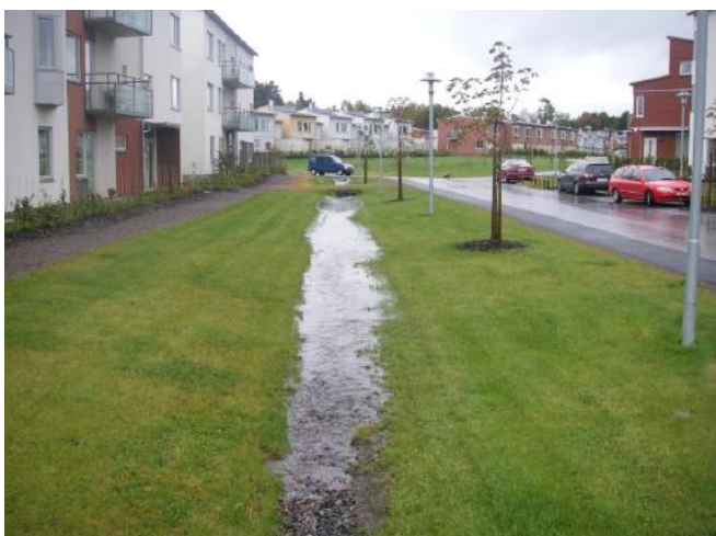
Figur 9. Foto makadamdike för fördröjning. Källa Svenskt Vatten.
